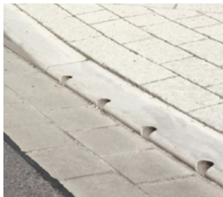
Bloques centrales con aberturas de entrada
