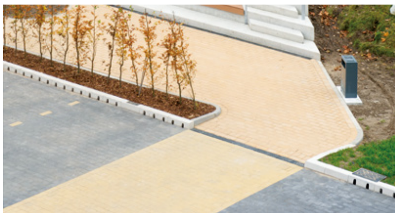
Un tramo con arqueta protege el sistema de alcantarillado de la sedimentación por lodo
