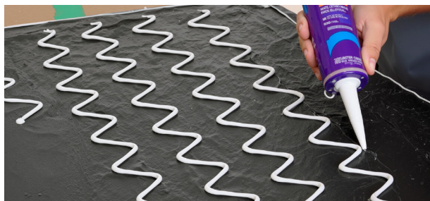
Imagen 2. Aplicación de adhesivo ▾
