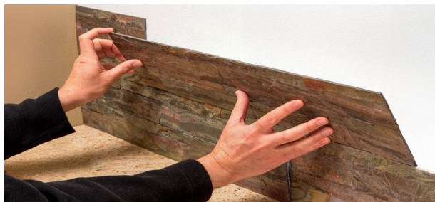
Imagen 3. Colocación de revestimiento ▾
