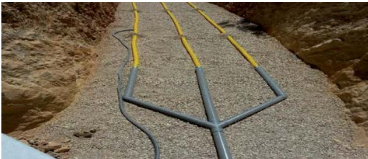
Tubos de drenaje sobre grava en zanjas
