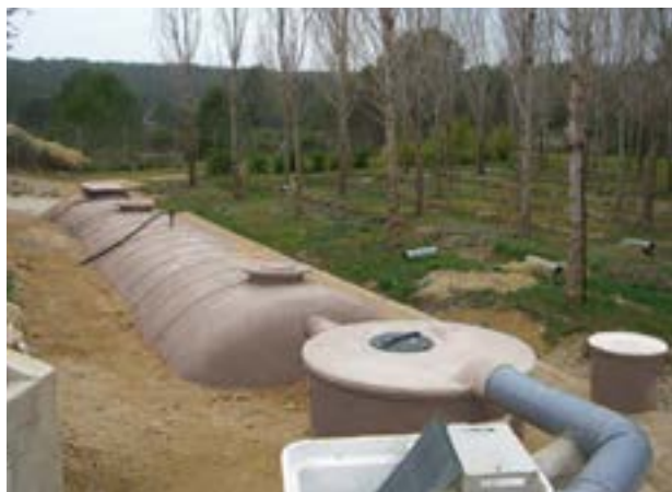
Instalación depuradora perfil hidráulico
