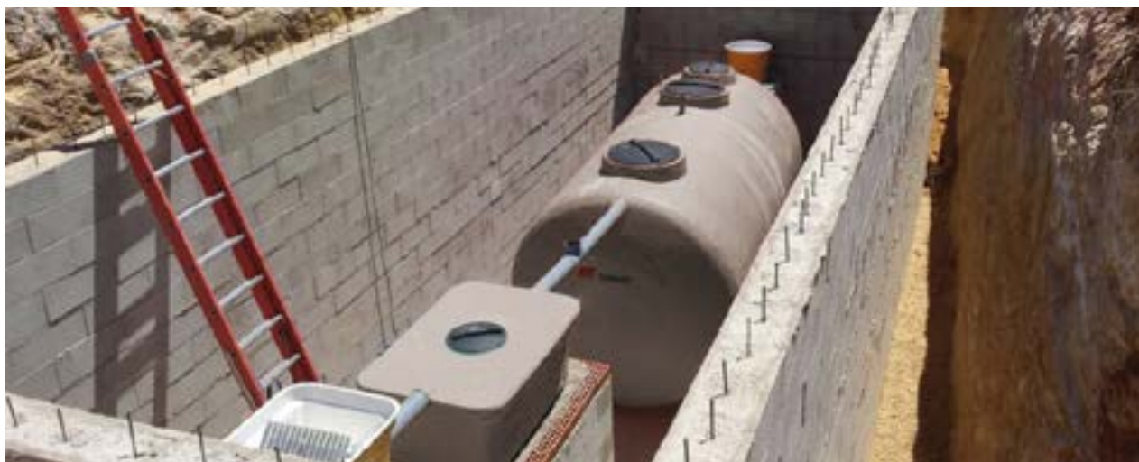
Instalación depuradora perfil hidráulico
