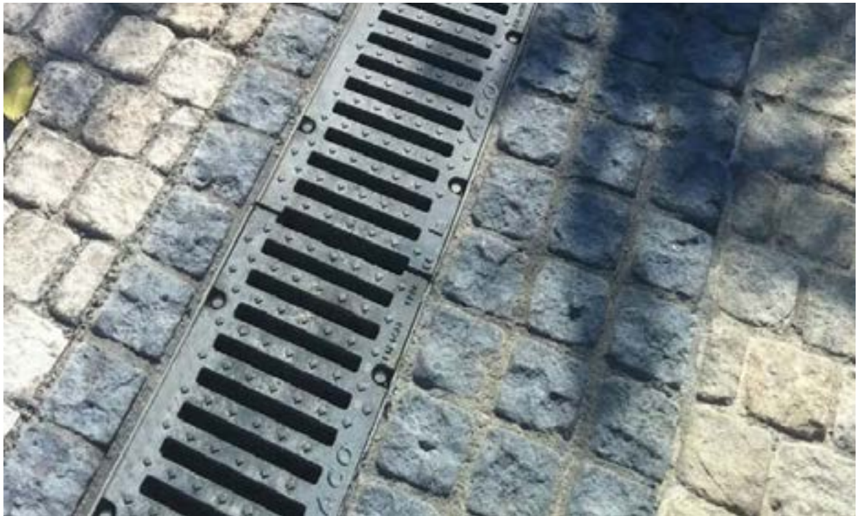
Detalle del canal instalado
