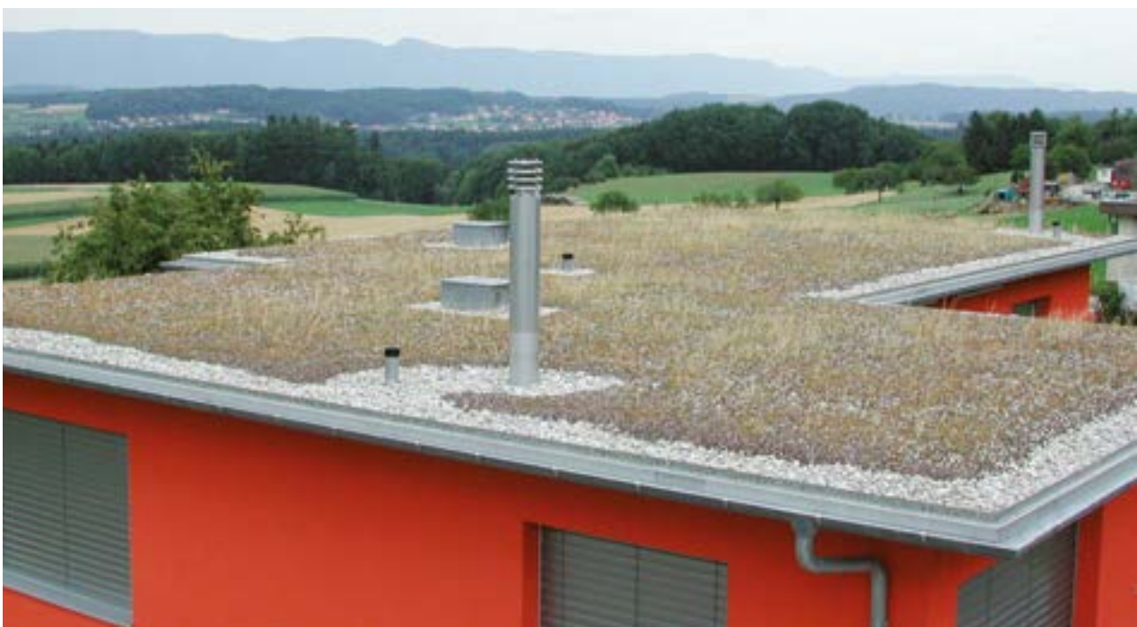
Ajardinamiento extensivo de cubierta
